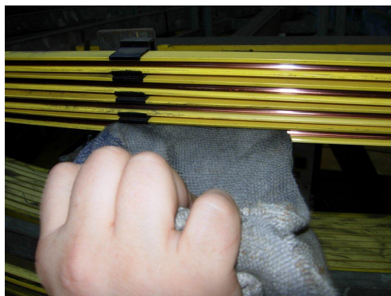
Imagen 9: Retire la suciedad de los soportes de rieles
