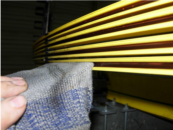
Imagen 10: Cambie el ángulo de acción de la herramienta de limpieza para limpiar distintas zonas
